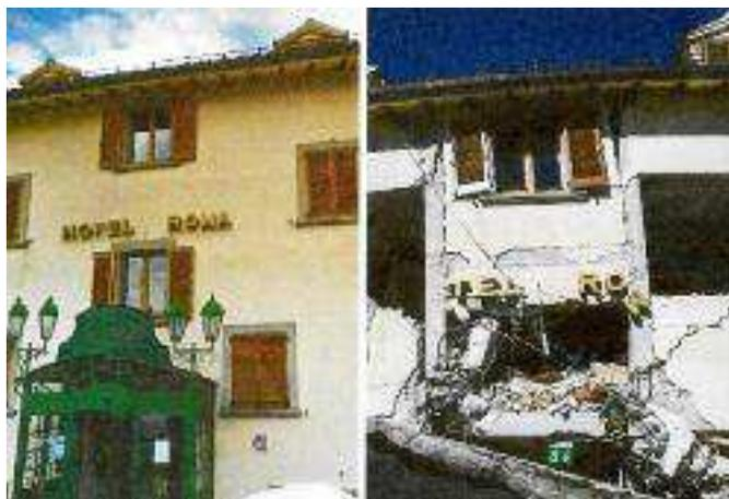
*Fig. 1 Amatrice, Hotel Roma prima e dopo l'evento sismico. L'aspetto esterno tradizionale nascondeva un robusto telaio in armatura di cemento. Vi furono vittime.*
